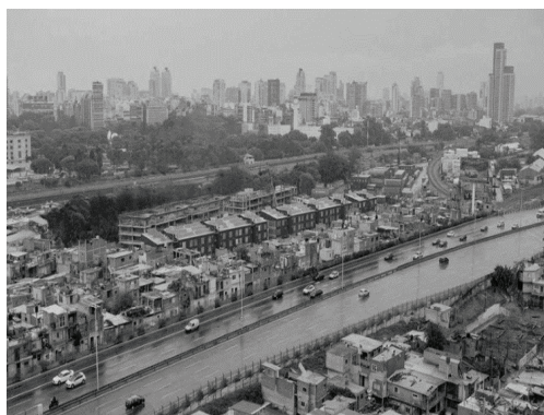
IMÁGENES 6 Y 7. VISTA DE LA VIVIENDA NUEVA EN LA VILLA 31-31 BIS (IZQUIERDA) Y EN LA VILLA 20 (DERECHA)
