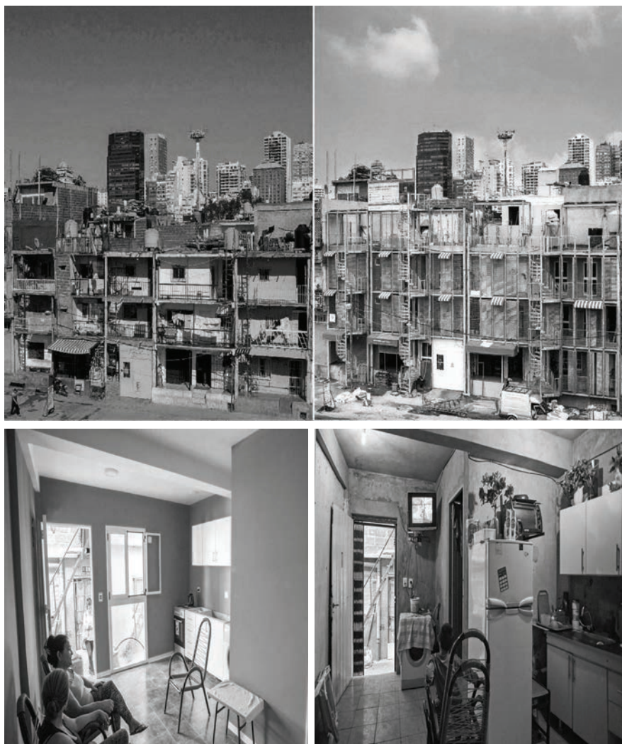
IMÁGENES 3, 4 Y 5. ANTES Y DESPUÉS DE LAS OBRAS DE MEJORAMIENTO INTERNAS Y EXTERNAS A LA VIVIENDA. VILLA 31 Y 31 BIS. CABA. 2017
